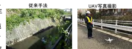
写真1 従来手法とUAV写真撮影の様子
